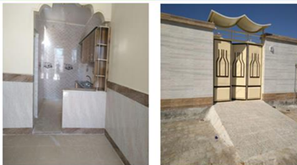
تعمیر اساسی و تجهیز خانه بهداشت پل نو خرمشهر
