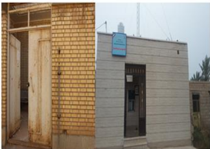
تعمیر اساسی و تجهیز خانه بهداشت ابوشانک نصارآبادان
