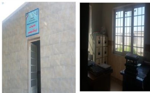
تعمیر اساسی و تجهیز خانه بهداشت ابوشانک بهمنشیر آبادان
