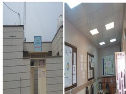
تعمیر اساسی و تجهیز خانه بهداشت ابو عبود آبادان
